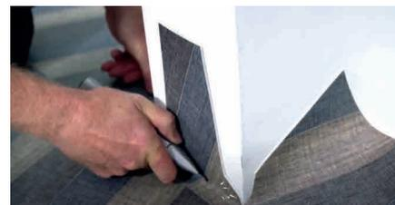
6. Con il materiale steso in piano intorno ai raccordi e agli angoli, è possibile eseguire il taglio finale lungo la lunghezza del muro.
